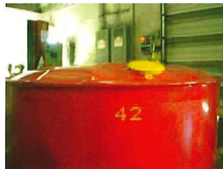
天板の膨らんだドラム
